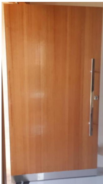
Figura 02: Porta de madeira com chapa de alumínio
