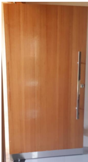
Figura 03: Porta de madeira com chapa de alumínio no rodapé com altura entre 10 e 15 cm
